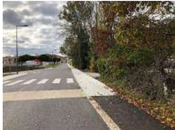
Travaux à Alboussière
