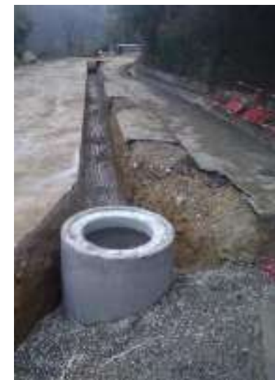
Travaux de réfection à Saint-Georges-les-Bains
