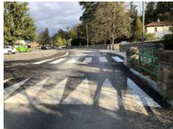
Travaux à Saint-Péray
