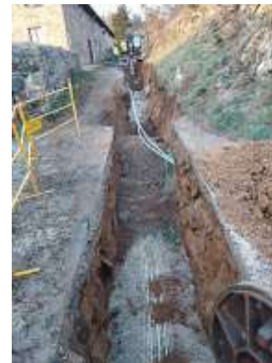
Travaux d'extension à Champis
